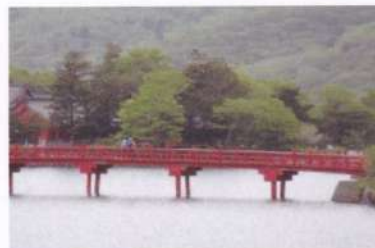
大沼に掛かるきつき橋
